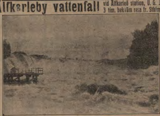
Älfrarleby vattenfall vid Älfrarleby station, U. G. J. 3 tim. bekväm resa fr. Stilm.
