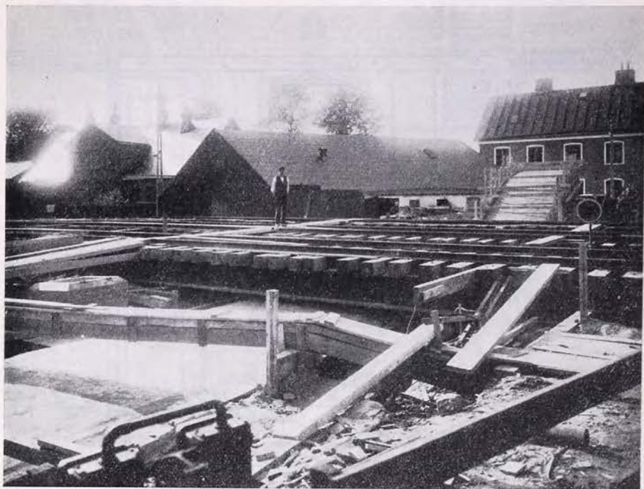
Bild 4. Arlöv. Tunneln färdiggjuten. De höjda spåren uppburna av provisoriska broar.
